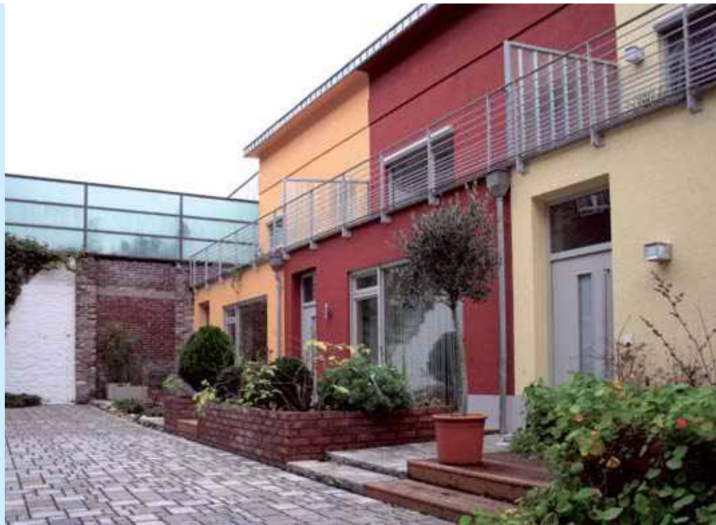
Projekt Nußbaumer Straße: Früher Schlachterei, heute moderne Stadthäuser.
